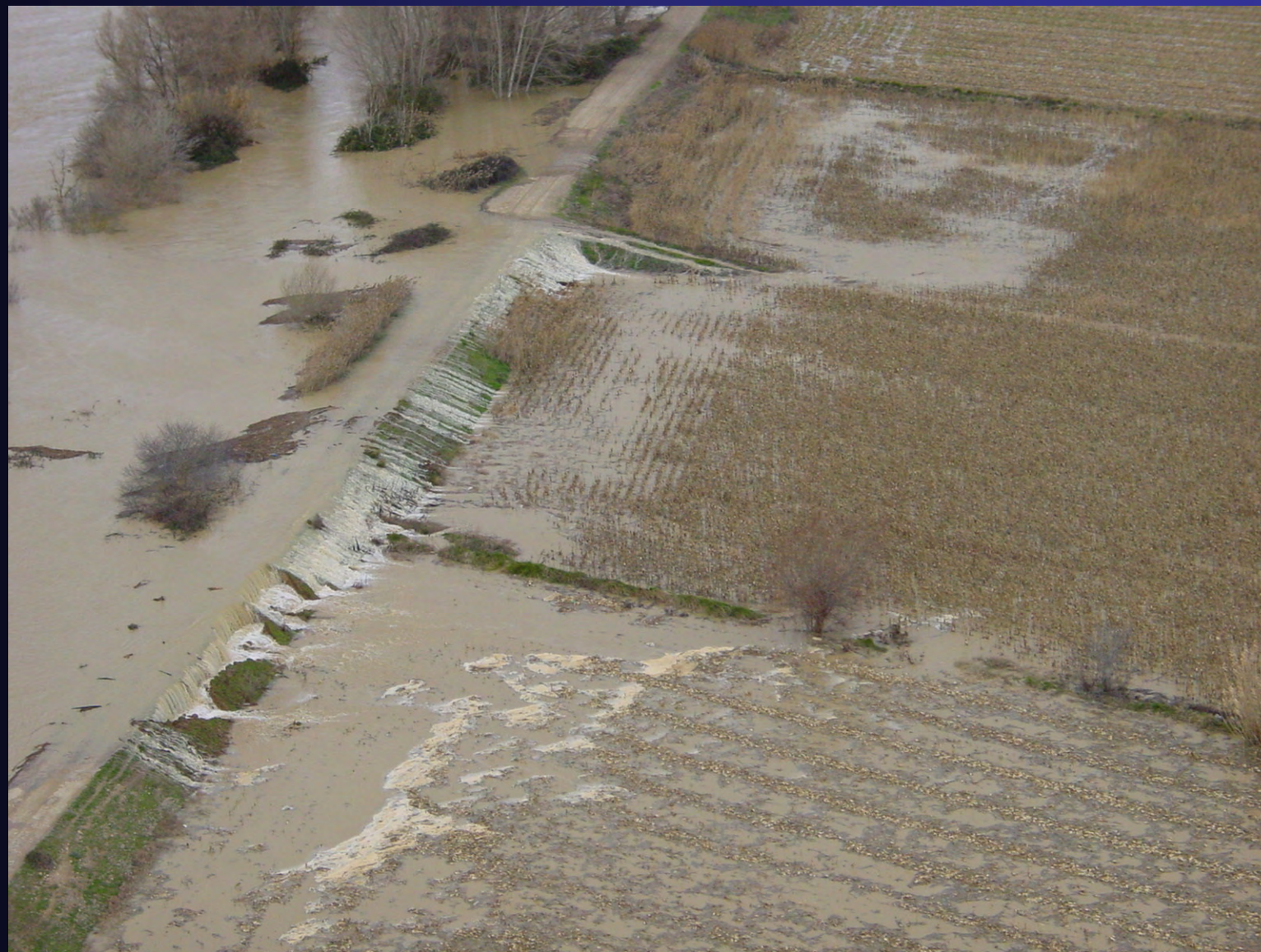
Desbordamiento de mota en el Ebro (febrero de 2003)
