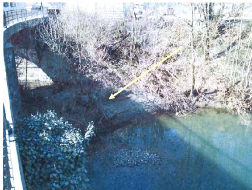
Detalle zona de actuación margen izquierda aguas abajo de puente
