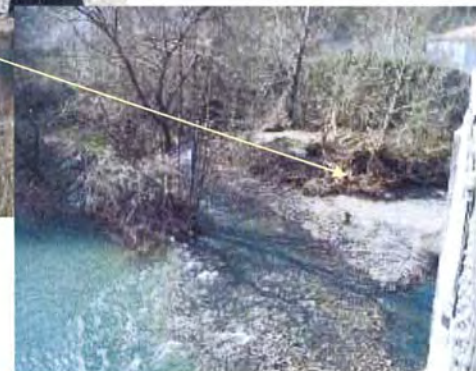
Detalle zona de actuación margen izquierda aguas arriba de puente
