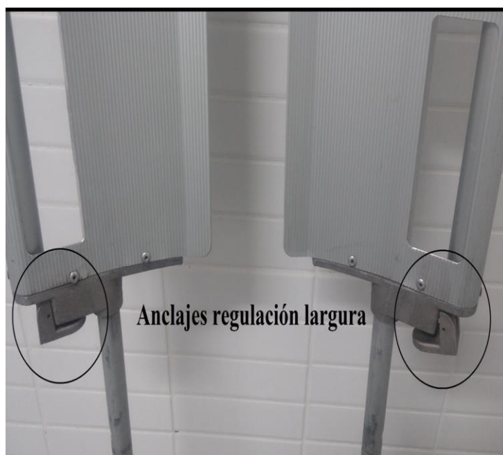
Foto 3. Regulación de anclajes en largura
