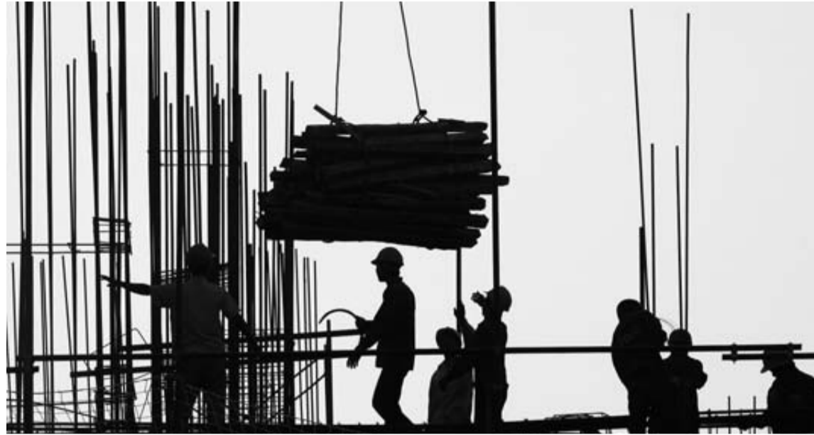
Varios trabajadores de la construcción.
