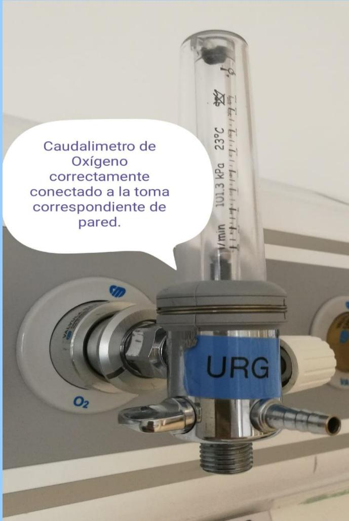
Caudalímetro de Oxígeno correctamente conectado a la toma correspondiente de pared.
