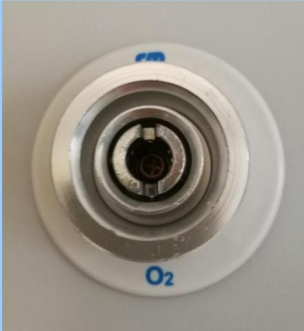
Fig. 13. Toma de O<sub>2</sub> a la pared
