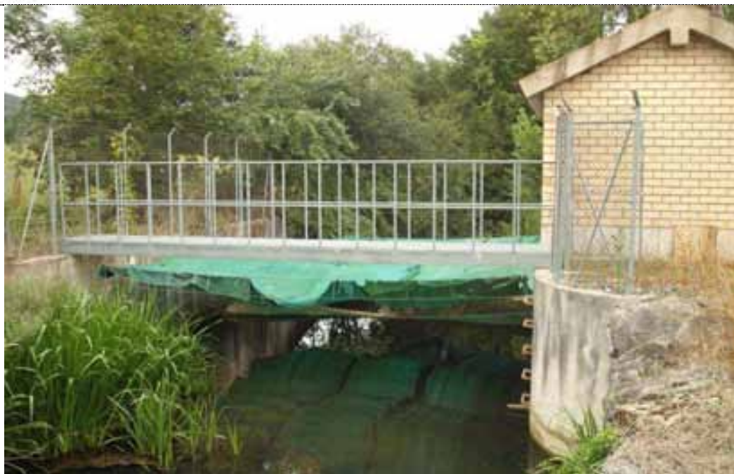
Fig. 4.8.5. Estación de Oskotz en aguas bajas con escasa circulación de agua, lo que intensifica el efecto del estiaje en la calidad de agua. Detalle de la lona para reducir la insolación en la época cálida.
